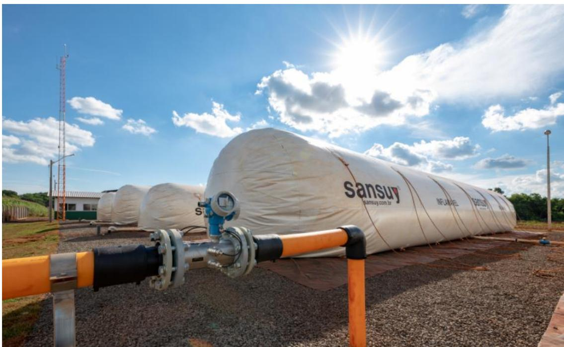
Figura 22 – Armazenamento de Biogás e Biometano em Gasômetros
