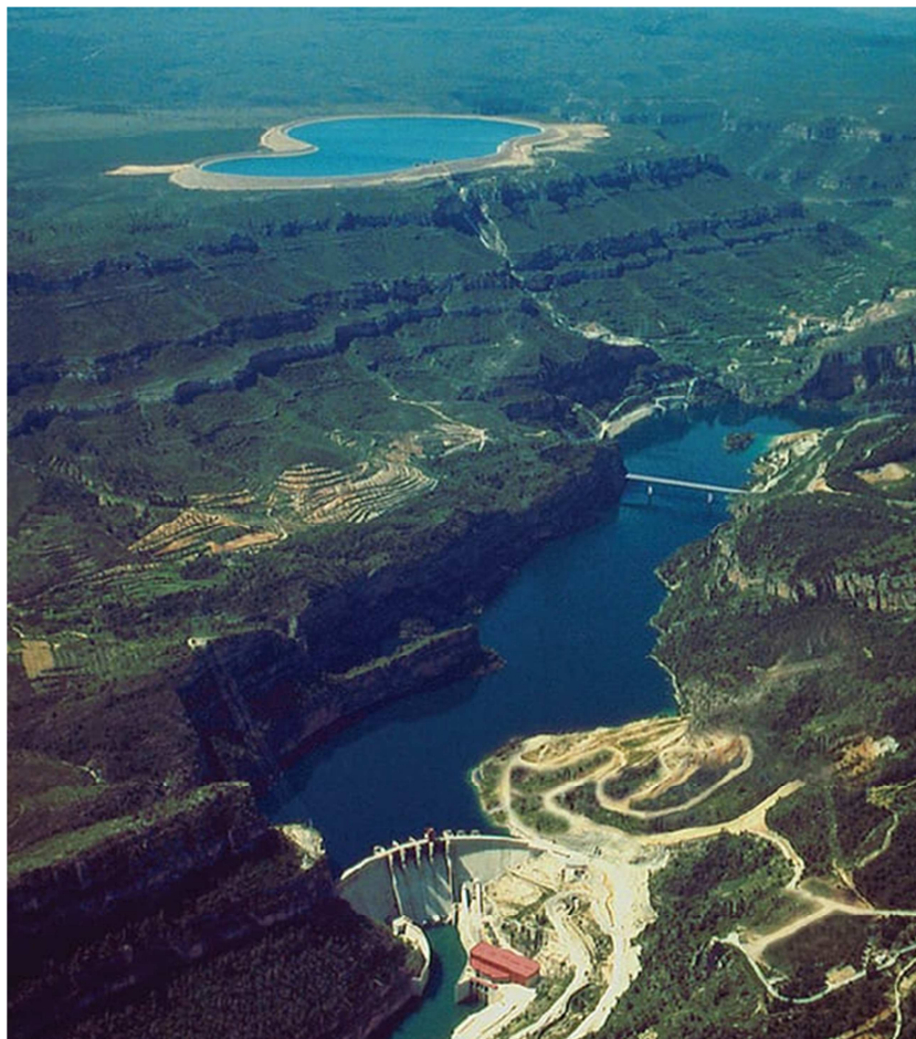
Figura 7: Vista aérea da UHR La Muela de Cortes
