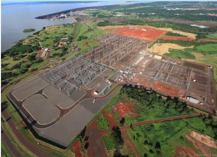
Ampliação da Subestação da Margem Direita de ITAIPU
